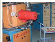
Модернизированная установка ННВ-6,6
